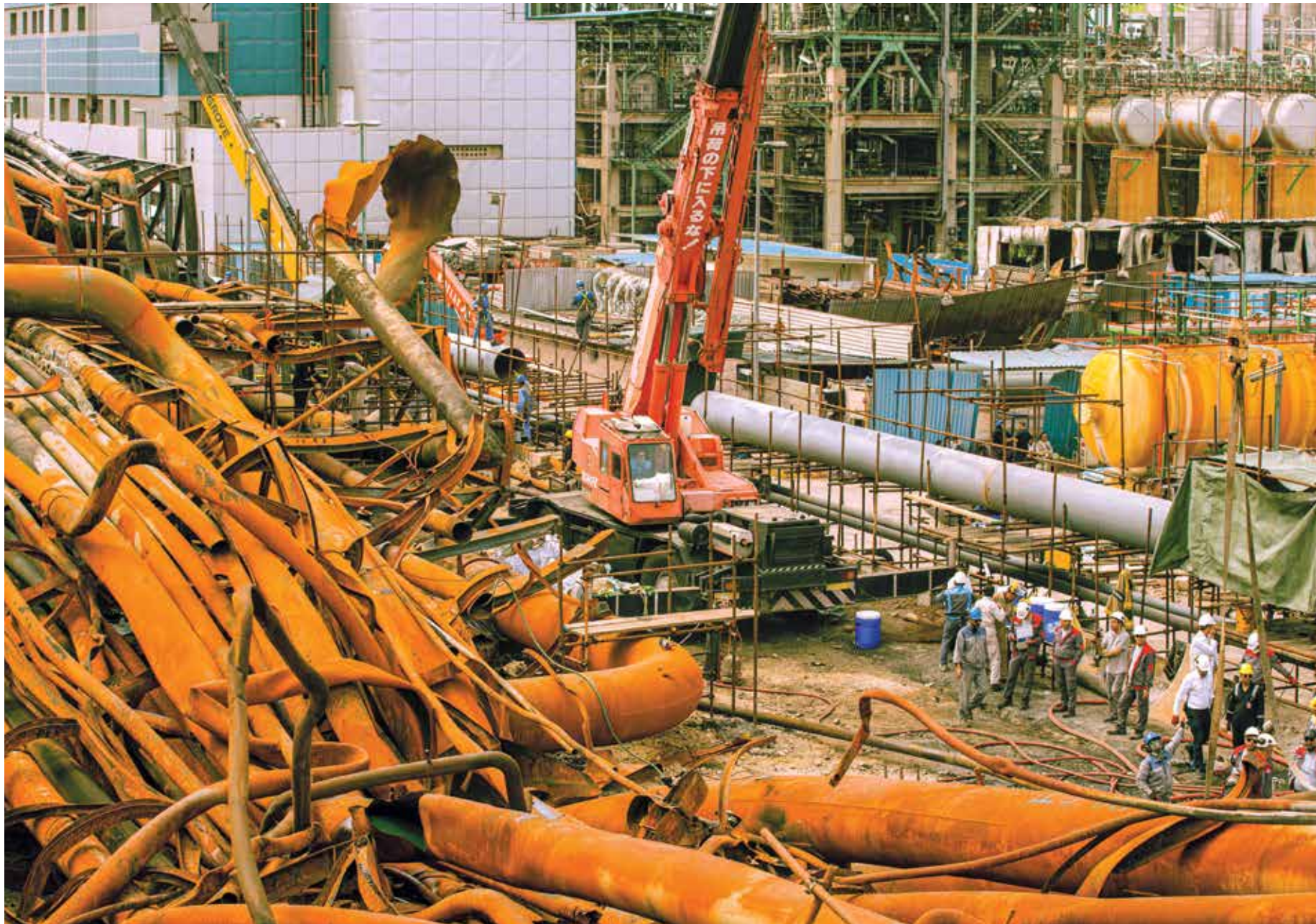
۱۴۰۵/۰۲/۰۳: آغاز عملیات آواربرداری در کریدور شرکت مبین انرژی؛ در میان پیچ و خم فلزات آسیب دیده، یک مسیر تازه آغاز می‌شد؛ مسیر بازسازی و بازگشت.
